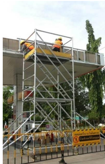
การทำงานบนนั่งร้าน
