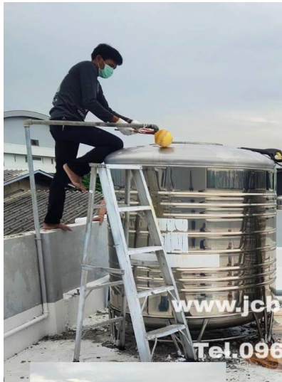
งานล้างแทงค์น้ำบนดาดฟ้า
