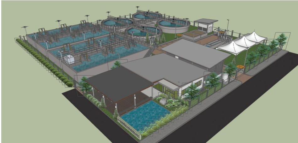
ภาพที่ 15 ระบบบำบัดน้ำเสียรวม (Central Treatment) ของมหาวิทยาลัยมหิดล ศาลายา
